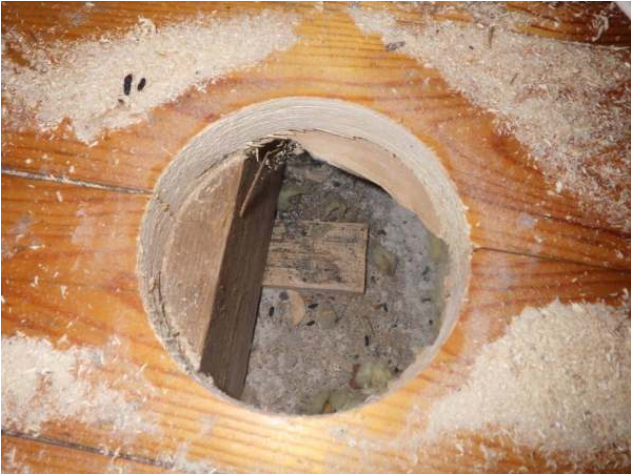
1. Rakenteen avaus alapohjaan tuvassa
