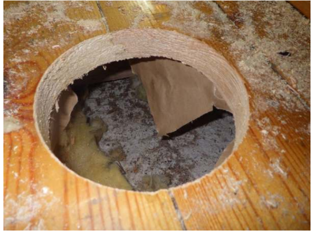
2. Rakenteen avaus alapohjaan keittiössä
