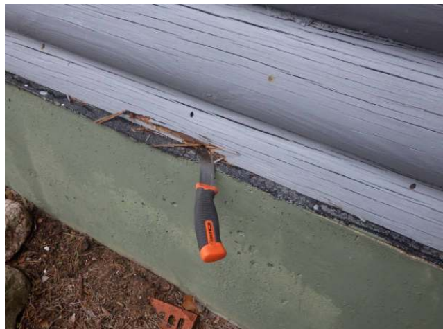
7. Lahoaa hirren alaosassa, hirressä hyönteisten tekemiä reikiä, huopa ja sokkelin yläreuna ohjaavat vettä hirteen
