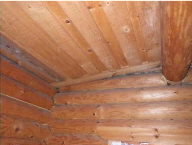
17. Yläpohjat ovat vesikaton suuntaisia
