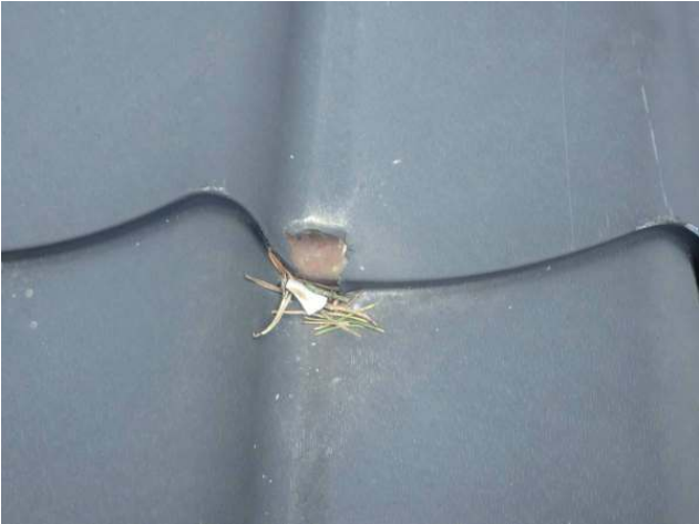
13. Ruostetta ja pinnoitteen irtoilua kattopellissä
