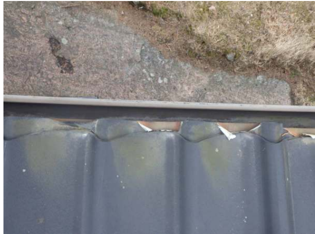
16. Ruostetta ja pinnoitteen irtoilua kattopellissä
